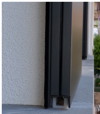
Particolare pattino di scorrimento inferiore
