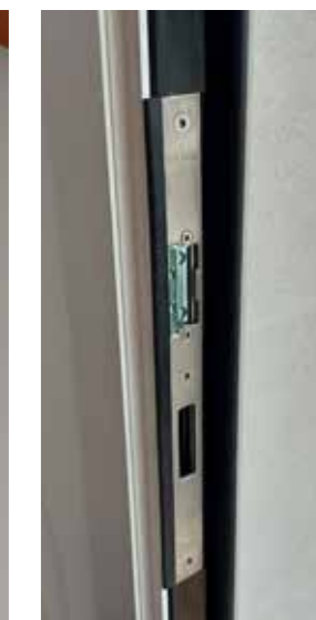
Incontro conplanare al telaio
