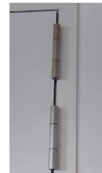
Cerniere a vista lato interno
